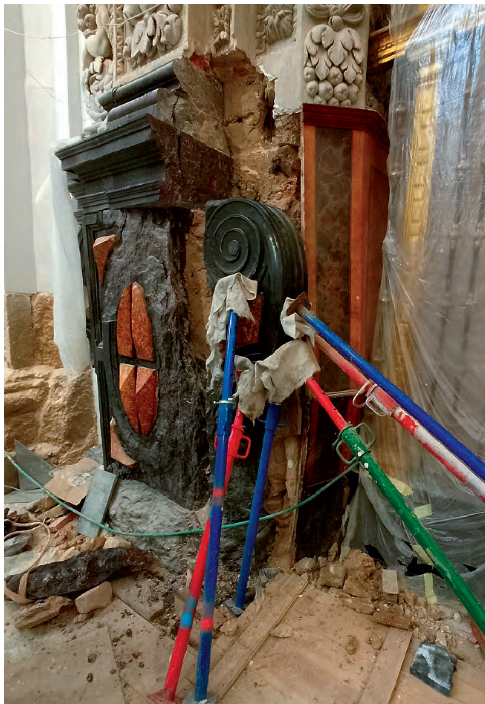
Fig. 10. Detalle del desmontaje parcial del basamento de la izquierda en la portada de la capilla de San Joaquín y Santa Ana.
