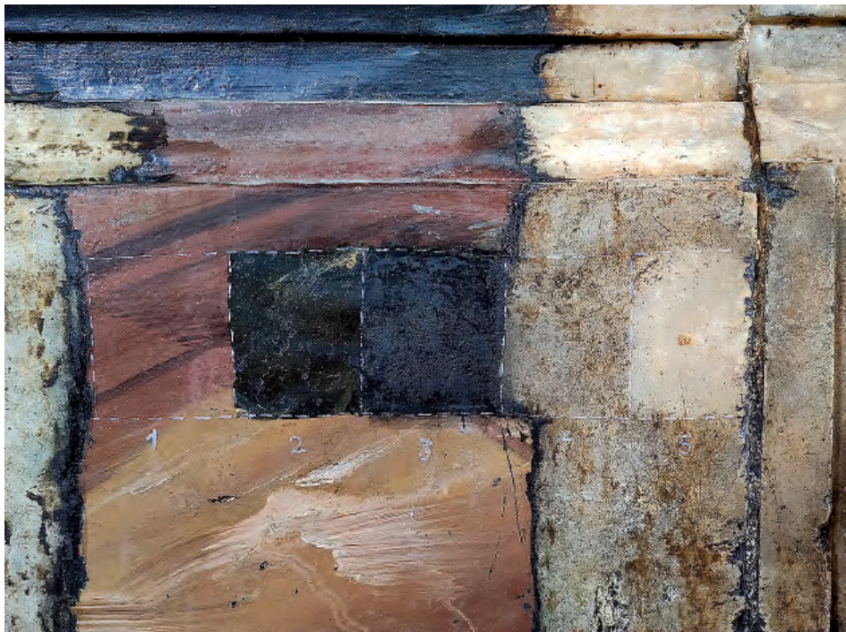
Fig. 12. Catas realizadas en uno de los bloques de alabastro que sirven de base a la reja de la capilla de la Inmaculada.
