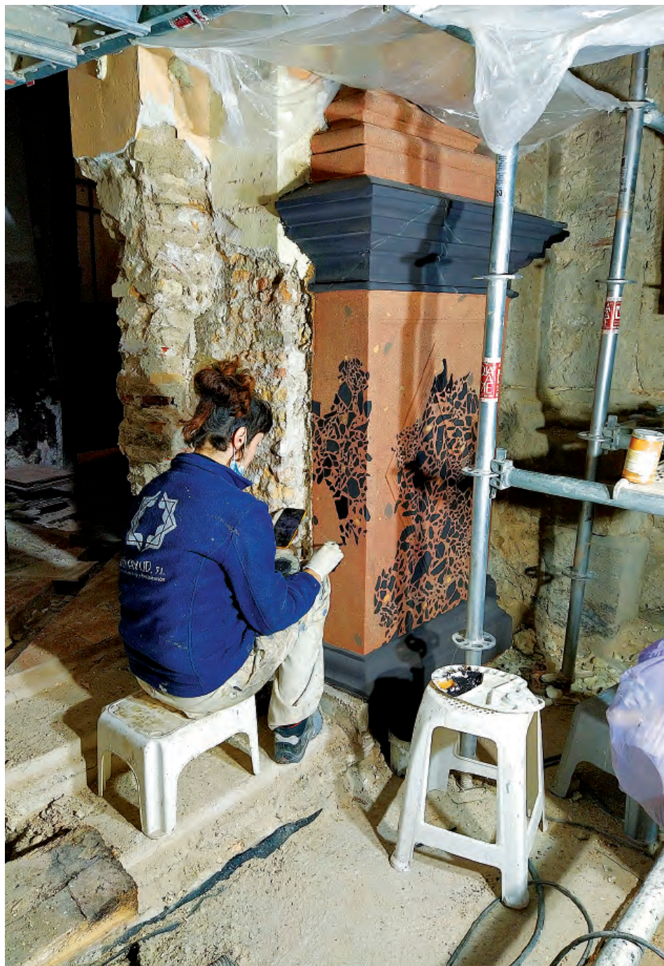
Fig. 14. Reproducción de jaspe de Ricla sobre basamento de madera en la portada de la capilla de la Soledad.
