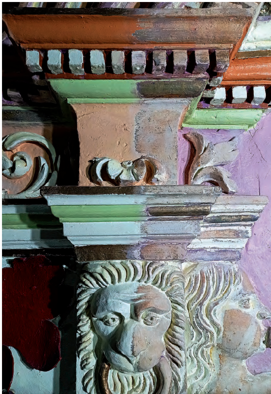
Fig. 13. Proceso de eliminación de repinte en la yesería de la portada de la capilla del Santo Cristo.
