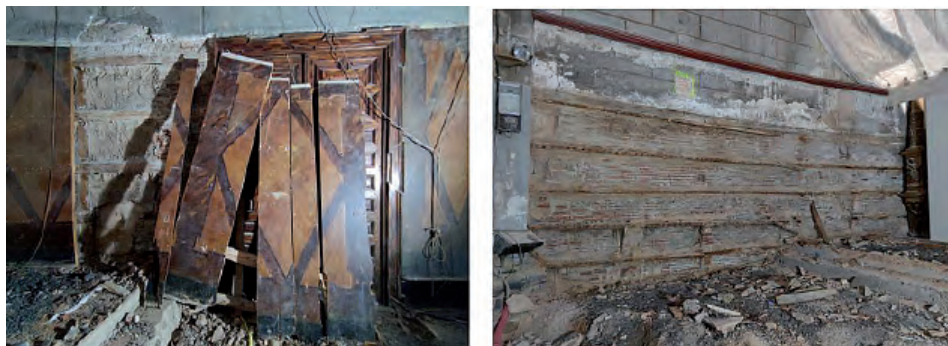
Fig. 18. Proceso de desmontaje del arrimadero.
