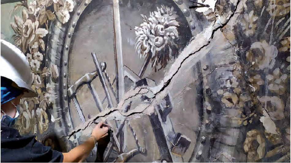
Fig. 7. Detalle de la grieta en la grisalla de la portada de la capilla de San José.
