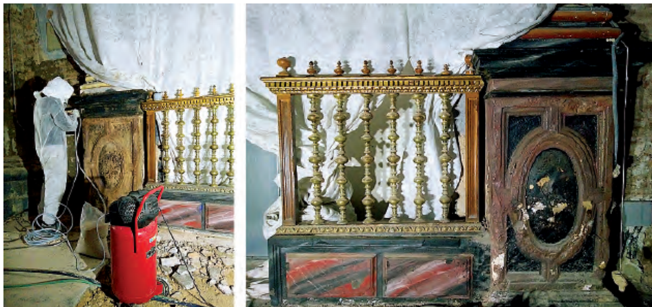
Fig. 1. Eliminación de repinte en la piedra del basamento de la portada de la capilla de la Virgen Blanca.
