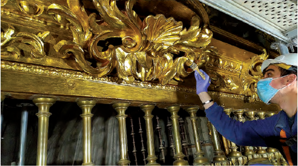
Fig. 15. Detalle de la crestería de la reja del coro.
