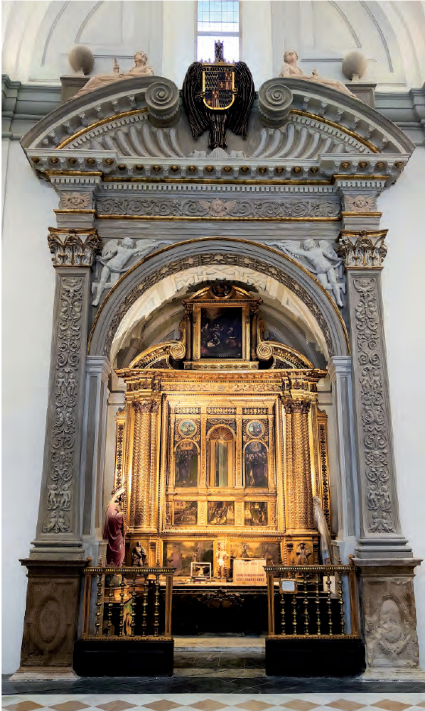
Fig. 3. Estado final de la portada de la capilla de la Virgen Blanca tras la restauración.
