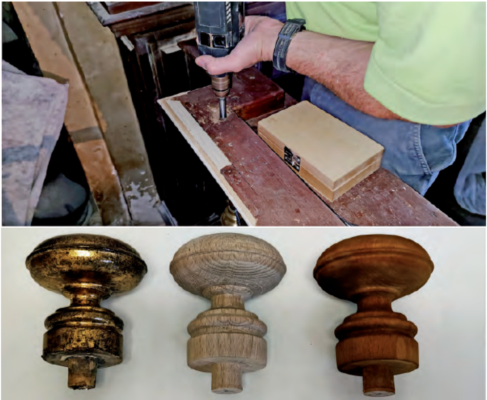
Fig. 16. Injetos de madera y reposición de elementos faltante es la reja del coro.
