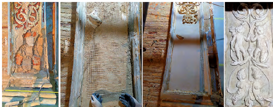
Fig. 2. Proceso de reconstrucción volumétrica en la pilastra izquierda de la portada de la capilla de la Virgen Blanca.
