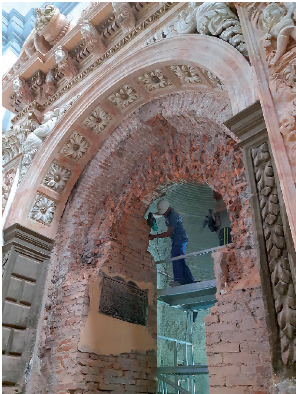
Fig. 7. Capilla del Santo Cristo. Eliminación del “refuerzo” de 1972, durante las obras de 2022.
