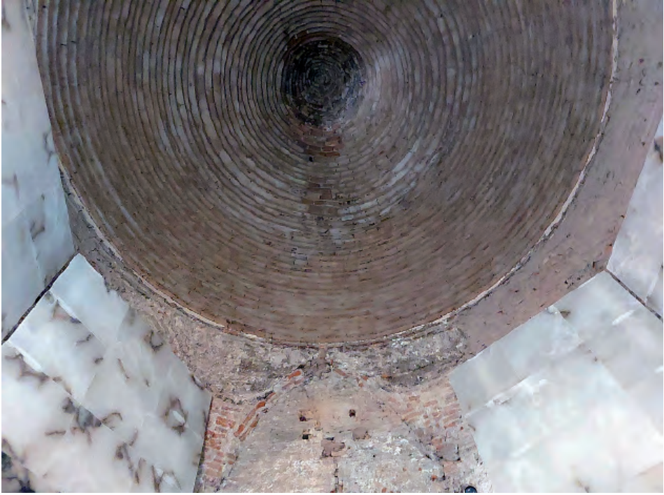
Fig. 8. Restos de la bóveda gótica original, demolida en 1972, visibles tras la actual restauración.
