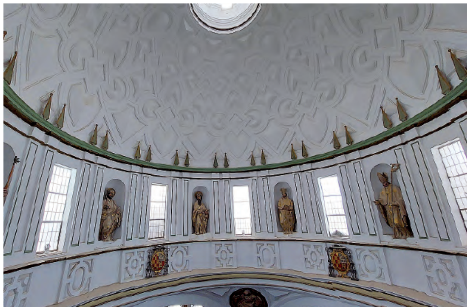
Fig. 15. Detalle de la cúpula a nivel del tambor, antes y después de su restauración en 2016, en la que se recuperaron los vanos de iluminación.
