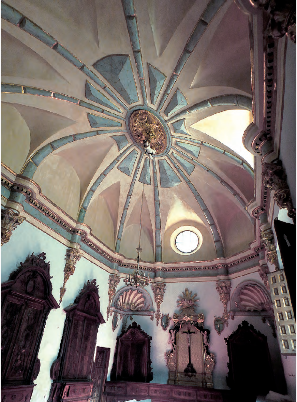
Fig. 19. La sacristía. Interior restaurado en 2014, con recuperación de su cromatismo original.
