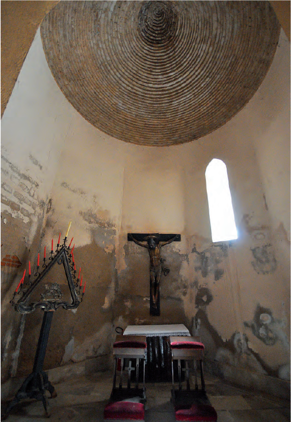
Fig. 3. Interior de la capilla del Santo Cristo, resultado de la intervención dirigida por Ramiro Moya en 1972. Fotografía de 2010.
