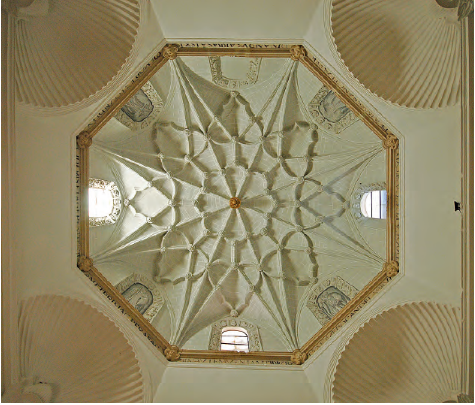
Fig. 2. Monasterio de Piedra. Solución de cierre de la antigua caja de la escalera (Javier Ibáñez Fernández).
