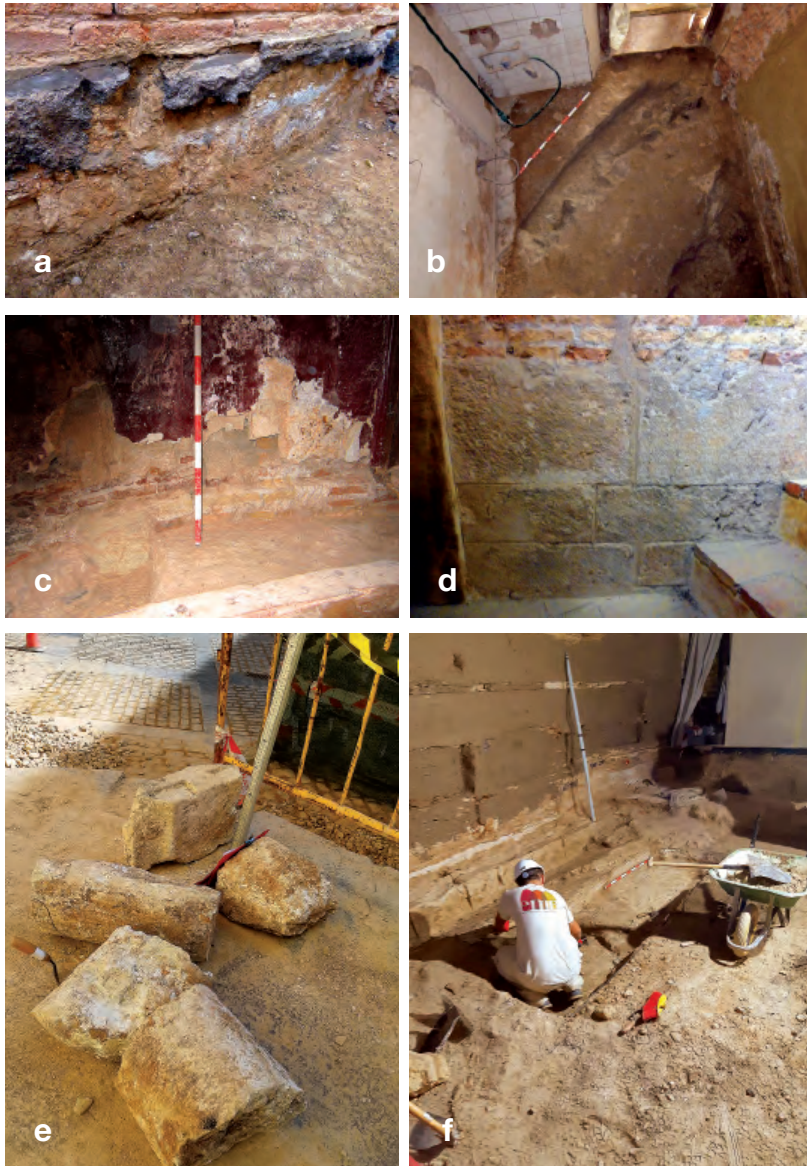
Fig. 4. Hallazgos en la cabecera, realizados durante diferentes fases de las obras de restauración: a) Hilada de alabastro perteneciente al ábside románico, conservada en la fábrica posterior de ladrillo en el exterior del ábside central; b) Arranque del ábside románico en el espacio ocupado por la caja de escalera de acceso al archivo capitular; c) Tramo del arranque del ábside meridional, aparecido bajo el acceso a la actual sacristía; d) Fábrica de sillería de alabastro conservada en la zona de acceso al claustro alto, perteneciente al muro septentrional del templo románico; e) Restos de sillares, semicolumnas y cornisas hallados en una zanja, al pie de lo que fue ábside meridional; f) Descubrimiento de la primera hilada del paramento interior del muro norte del ábside central.
