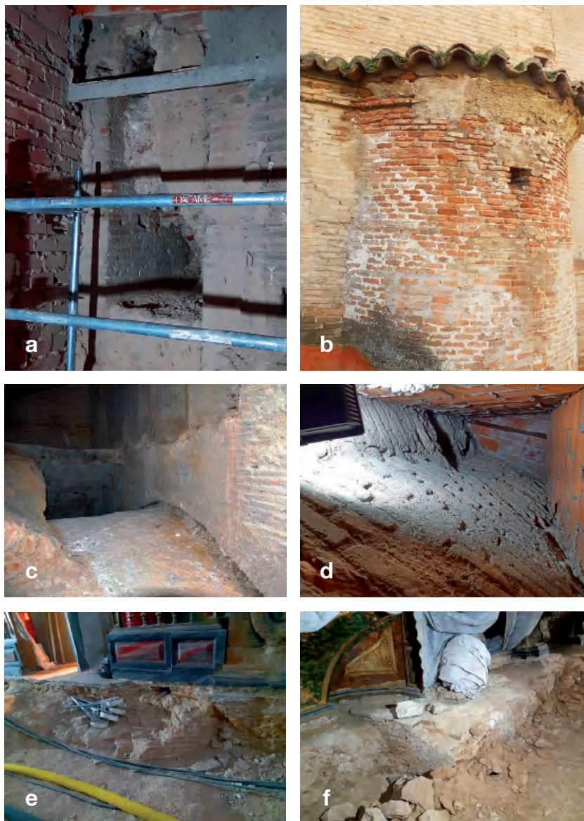
Fig. 5. Hallazgos relacionados con la fábrica de ladrillo del cuerpo de naves del primitivo templo medieval: a) Cara exterior del ventanal correspondiente al muro del transepto norte, descubierta en el espacio bajo-cubierta del claustro; b) Tramo superior de la torre-contrafuerte que se situaba en el extremo norte del hastial occidental de la iglesia medieval; c) Aspecto de la fábrica medieval del transepto norte conservada hasta una altura de doce metros en el espacio bajo-cubierta del claustro; d) Tramo intermedio de la torre-contrafuerte situada en el extremo norte del hastial occidental; e) Arranque de la torre-contrafuerte que se situaba en el extremo sur del hastial occidental y ha aparecido bajo el acceso a la capilla de san Paterno; f) Arranque de un tramo del hastial occidental, aparecido bajo el trascoro actual.
