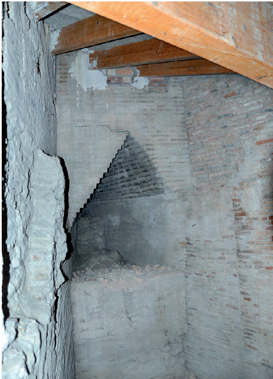
Fig. 8. Solución dada en el contrafuerte del siglo XVII al paso o acceso desde una probable torre-contrafuerte perteneciente a la fábrica medieval del muro norte, más adelantada. La falsa bóveda de ladrillo se apoya en las estructuras medievales del muro norte (a la izquierda) y de la sala capitular vieja (derecha).
