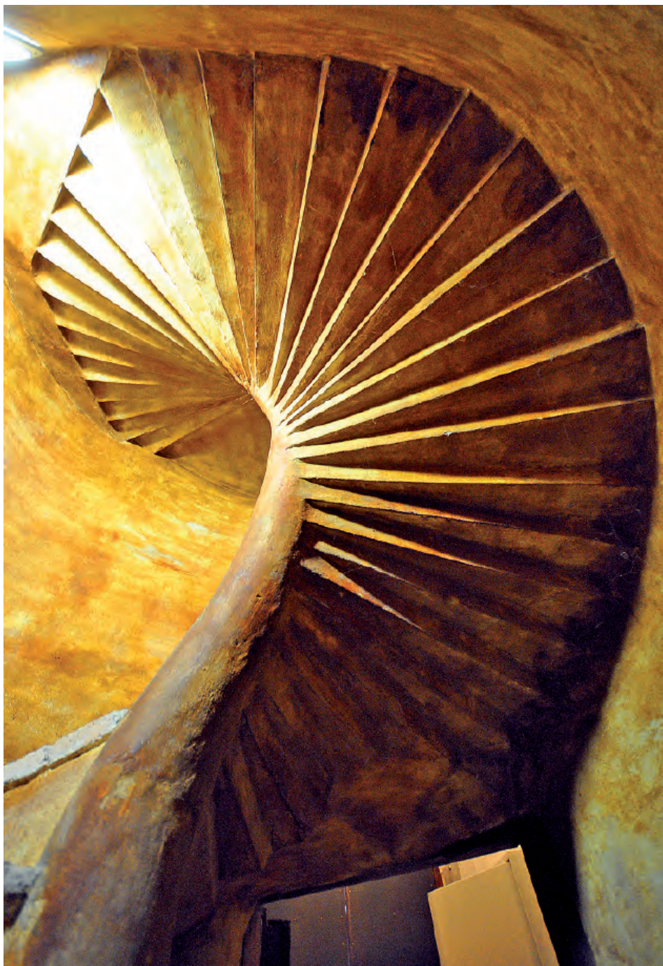
Fig. 7. Desarrollo interior de la escalera que actualmente sirve de acceso de acceso a la torre-campanario, adosada al muro norte del templo.
