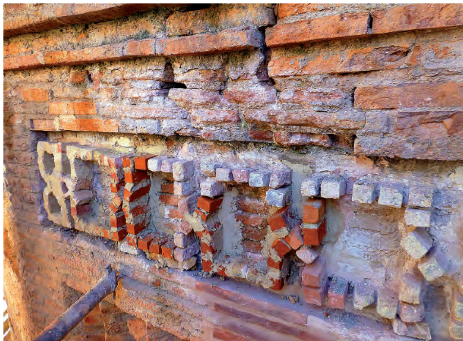
Fig. 20. Detalle de la ejecución de la lacería en el ábside, realizada con pequeños tacos de ladrillo. Fotografía tomada durante su restauración en 2016.
