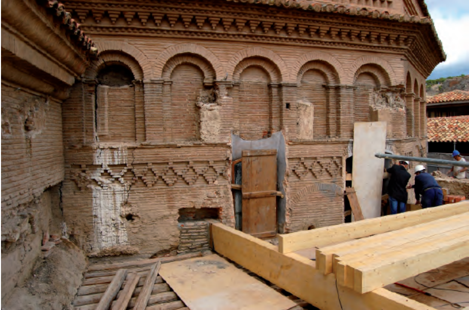
Fig. 30. Fábricas del siglo XVI, visibles durante las obras de restauración del ábside, en 2016, correspondientes a su flanco meridional, oculto por el volumen de la sacristía.
