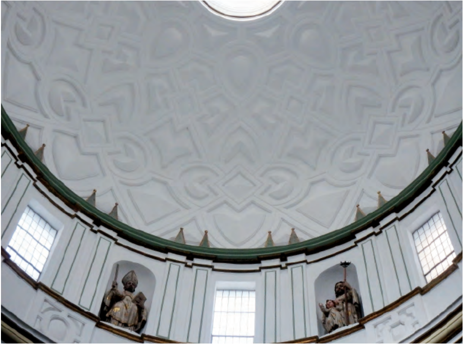
Fig. 44. Aspecto parcial del interior de la cúpula, con la ornamentación de yesos cortados y su efecto plástico, una vez recuperado su acabado blanco original.
