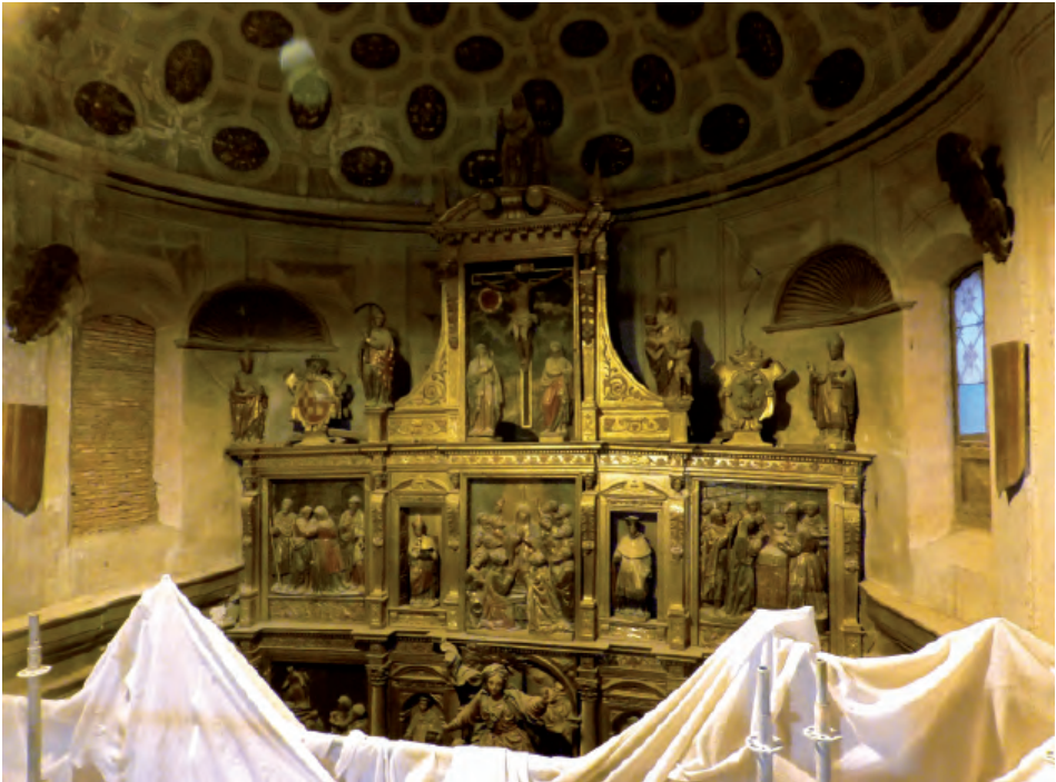
Fig. 39. Perfil superior del retablo mayor, visto frontalmente, durante las obras de 2012. Puede apreciarse el cegado de los vanos previstos y la forzada solución de encuentro de los remates laterales del retablo con el muro de cierre, que rompe el orden previsto en el muro.
