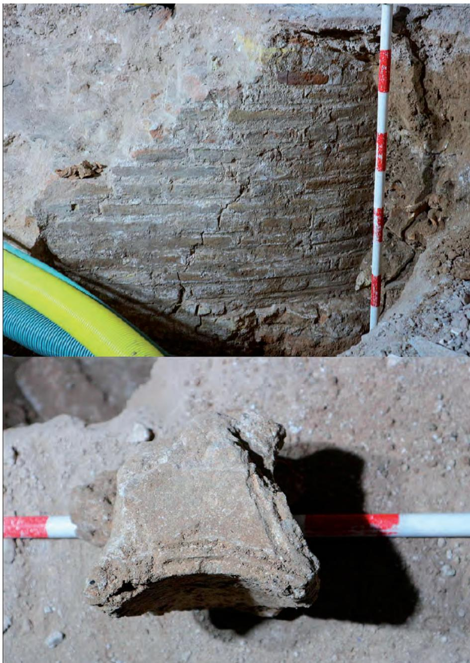
Fig. 12. Cata 2. Detalle del contrafuerte circular del ángulo de los pies y fragmento de arquillo lobulado que debía decorar esta parte del templo.
