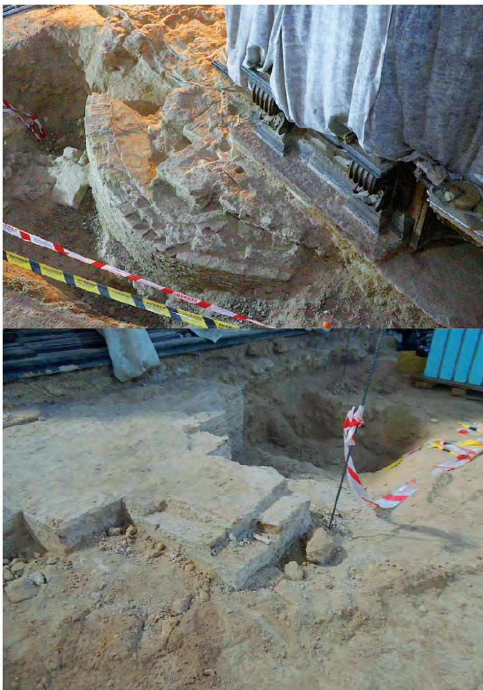
Fig. 13. Arriba, Cata 4. Refuerzo de los pilares cruciformes del siglo XIII, construido antes de la reconstrucción de la Colegiata. Abajo, Cata 5. Detalle de uno de los pilares cruciformes del templo.
