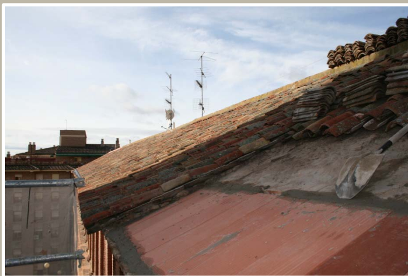
Obras en la cubierta
