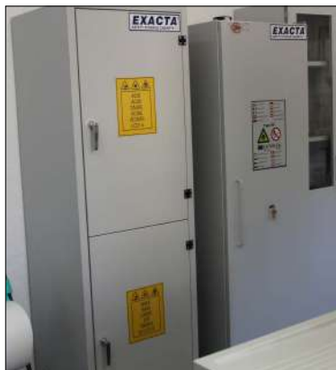
Armarios de seguridad para productos tóxicos
